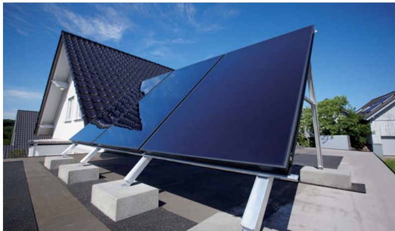
Praktické riešenie – solárne kolektory typu drain-back.
