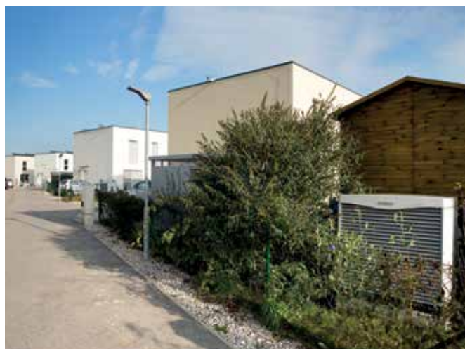
Vonkajšia jednotka tepelného čerpadla je jedna z najtichších na trhu. Vďaka tomu je systém vhodný aj do hustejšie zastavaných štvrtí.
